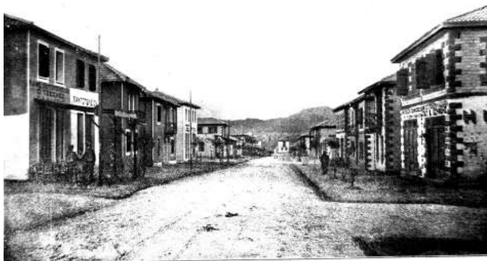
LA RUE DU MARCHÉ A IONIA (quartier urbain près Athènes).
