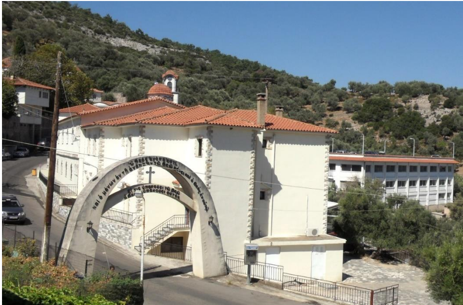
Abb. 5: Modernes Tor bei der Einfahrt zur Abtei des hl. Rafael, Aufnahme von Despina Costa, 2010.
