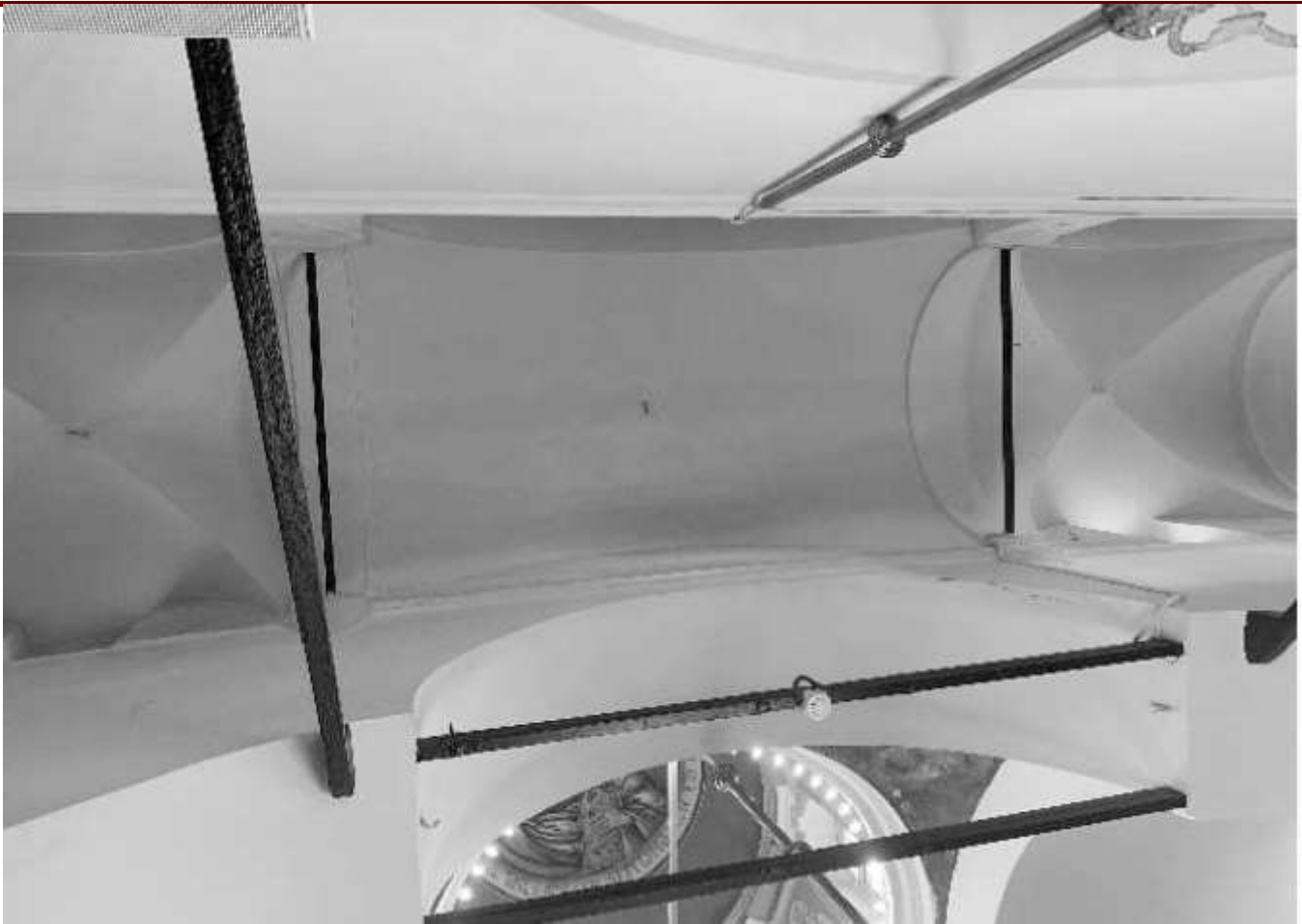
Καμάρες του δυτικού τμήματος του ναού
